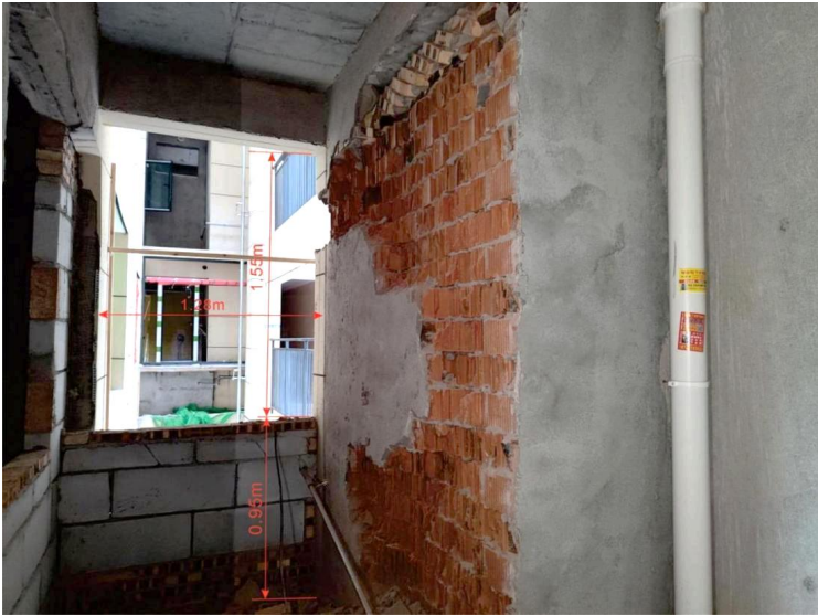
图2 2XXX室厨房打墙施工作业现场（室内）
