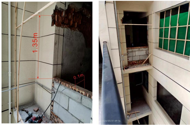
图3 2XXX室厨房打墙施工作业现场（室外）
